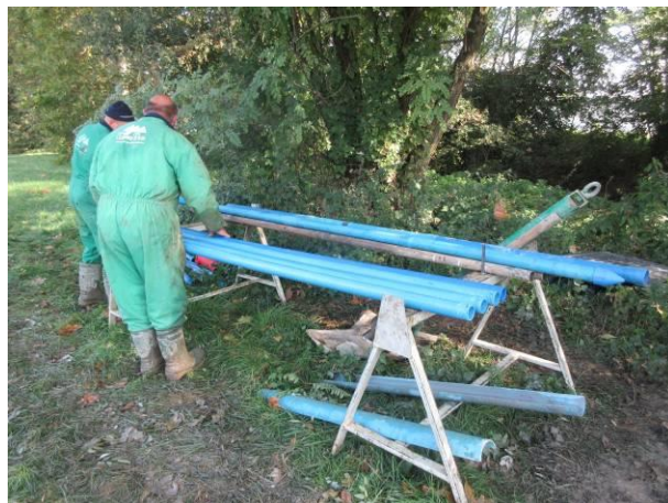
Tubo piezometrico
